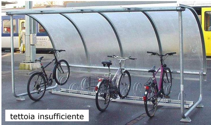
vento, con angolo di incidenza non esattamente perpendicolare al terreno. La copertura prevista deve quindi prevedere sempre, nelle direzioni in cui essa è aperta lateralmente, un minimo di 40 cm. di protezione in eccedenza rispetto all'ingombro di una bici standard.
