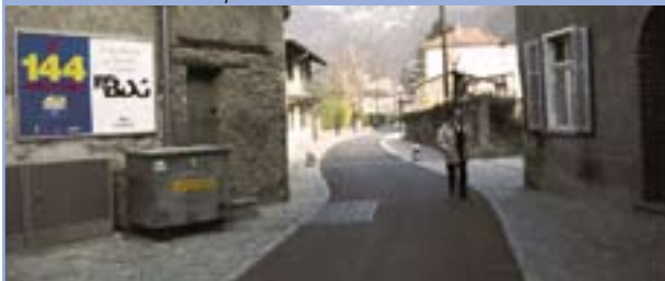
9. la stessa strada dopo l'intervento
