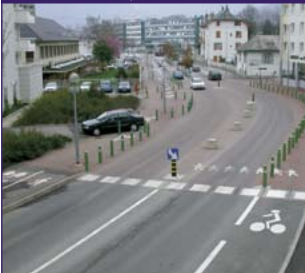
3. rialzamento con restringimento della carreggiata e puntelli con creazione di un tracciato per biciclette
