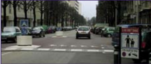
2. rialzamento con marcatura al suolo e segnaletica verticale (dopo)
