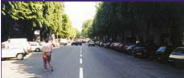
1. situazione prima dell'intervento
