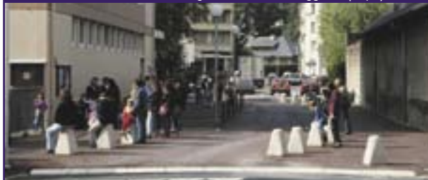
10. un rialzamento con restringimento della carreggiata (dopo)
