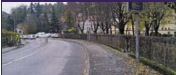
7. situazione prima dell'intervento
