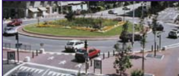
5. rotonda con rialzamento pedonale (dopo)
