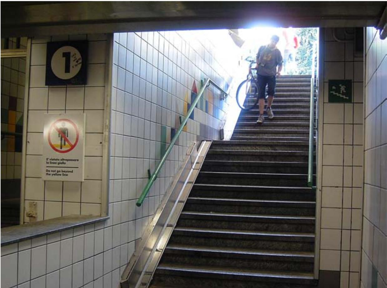
Foto 38 - Rho: sottopassaggio con canalina prototipo.
