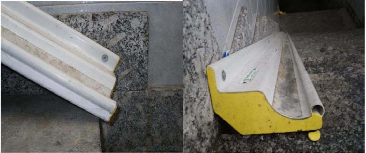
**Foto 115 e 115bis - Varese: installazione fuori misura e fragilità della plastica.**
