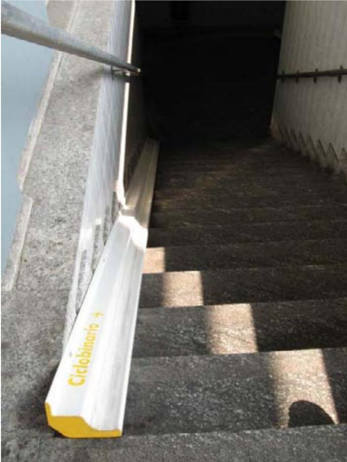
**Foto 113 - Varese: primo prototipo di canalina RFI. Scanalatura poco incavata (2008).**
