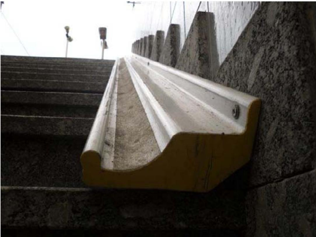
**Foto 114 - Varese: prototipo standard canalina RFI in plastica (2009).**
